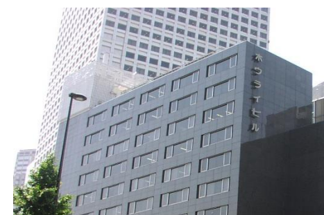
賃貸ビルの運営
