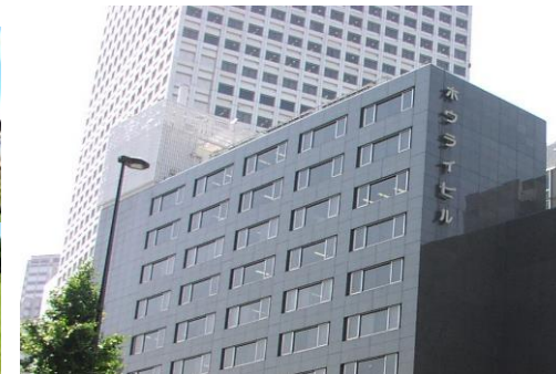
賃貸ビルの運営
